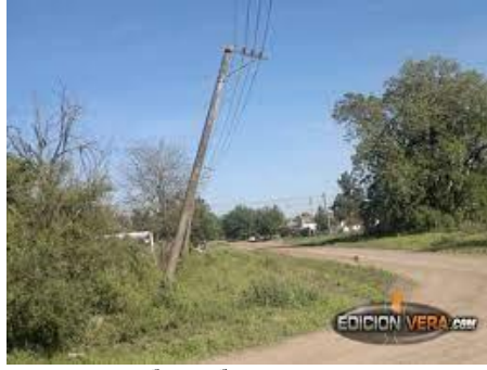
POSTACIÓN ELÉCTRICA PELIGROSA
