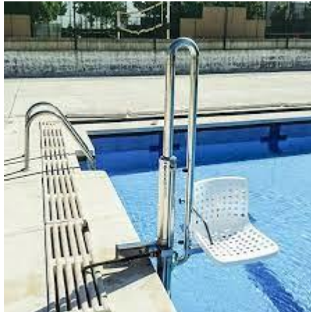
Elevador Hidráulico (de fondo escalera de ingreso)
